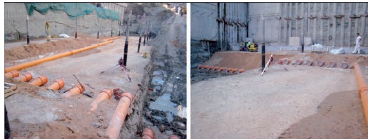
Proceso de ejecución de intercambiadores aire-tierra con los intercambiadores verticales tierra-agua ejecutados.
