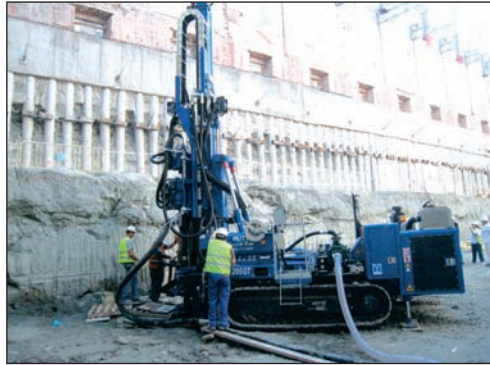
■ Equipo de perforación de sondas geotérmicas y balsas de decantación de lodos.
