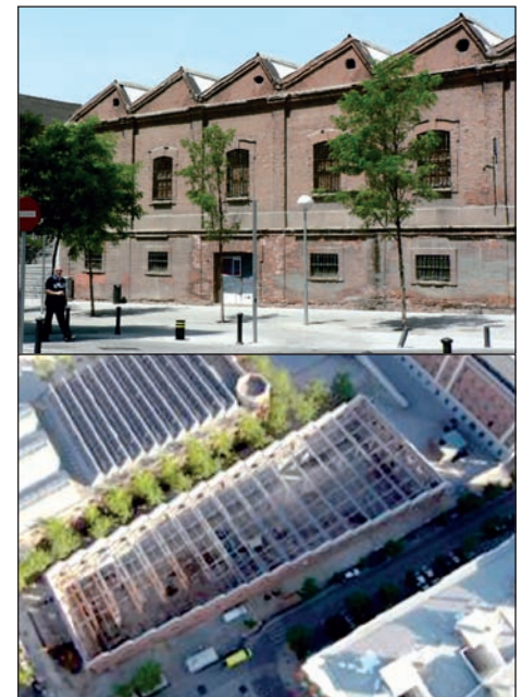
La obra de construcción del nuevo teatro supone la rehabilitación integral de un antiguo cuartel, protegido, en un entorno urbano. La aplicación de intercambiadores geotérmicos para la climatización eficiente del edificio supone un aporte calidad ambiental y un ahorro energético muy importantes en un proceso de rehabilitación.
