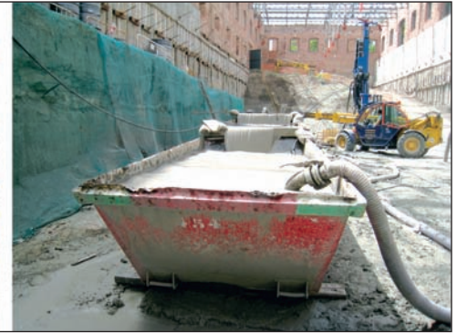
■ Equipo de perforación de sondas geotérmicas y balsas de decantación de lodos.
