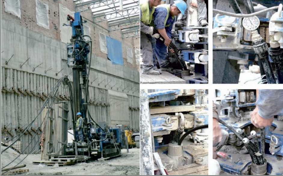
Introducción de la sonda doble de intercambio geotérmico, pruebas de estanqueidad e inyección de la perforación.
